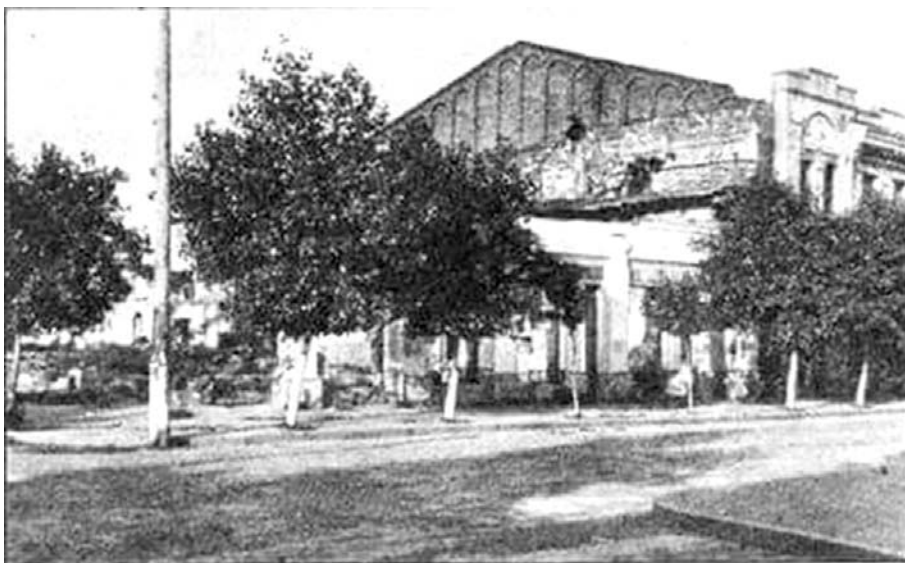
Напівзруйнована будівля готелю «Царград». Фото післявоєнних років
